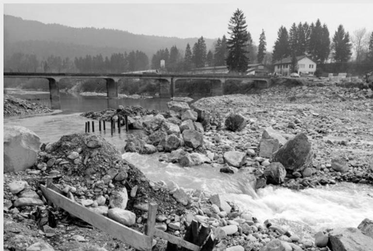
Das Foto von Helmut Klapper aus dem Jahr 1976 zeigt die Bauarbeiten für die Sohlschwelle unterhalb der Brücke Wolfurt-Kennelbach. Die hier noch zu sehende erste Stahlbetonbrücke des Kaiserreichs (errichtet 1904) wurde 1979 erneuert.
